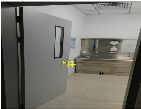
图 8-5 综合楼一楼急诊 DSA 室北侧
